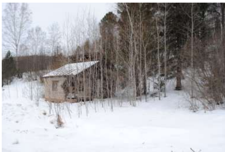
Разрушенный родниками дом.
